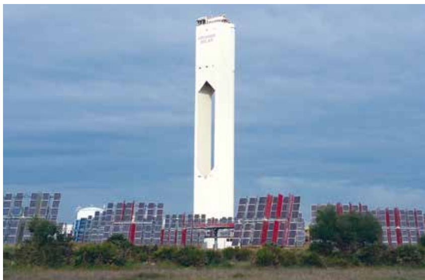
Elektrownia słoneczna Solaben firmy Abengoa w Hiszpanii
